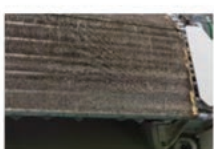
Krok 1 Špinavá vnitřní jednotka klimatizace
